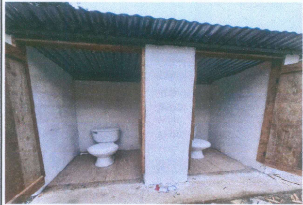
Foto 2: Instalación de un sanitario
