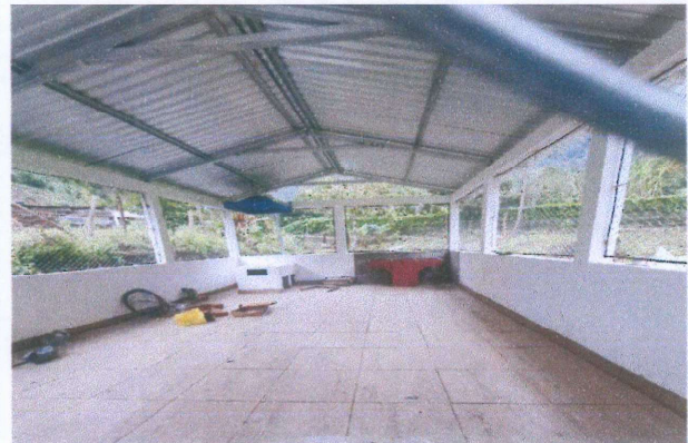
Foto 2: Instalación de lámina troquelada calibre 26
