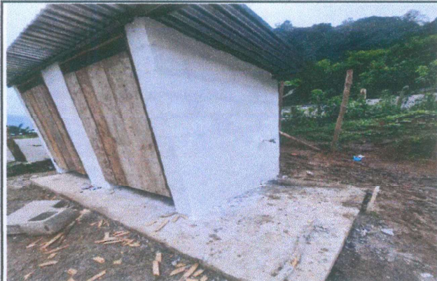
Foto 4: Lámina troquelada calibre 26 en el área de sanitarios
