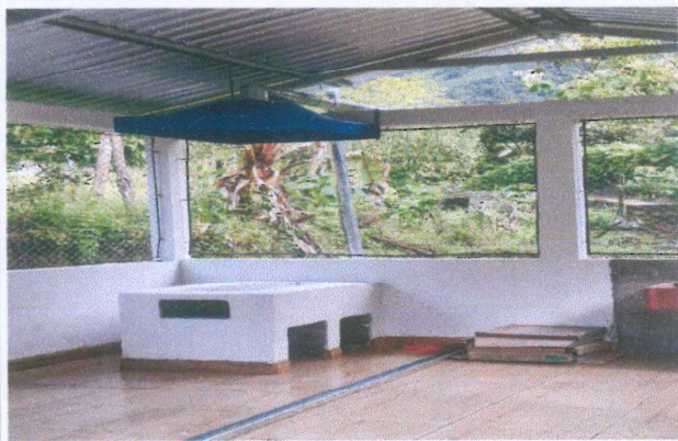
Foto 4: Instalación de polletón para el área de cocina
